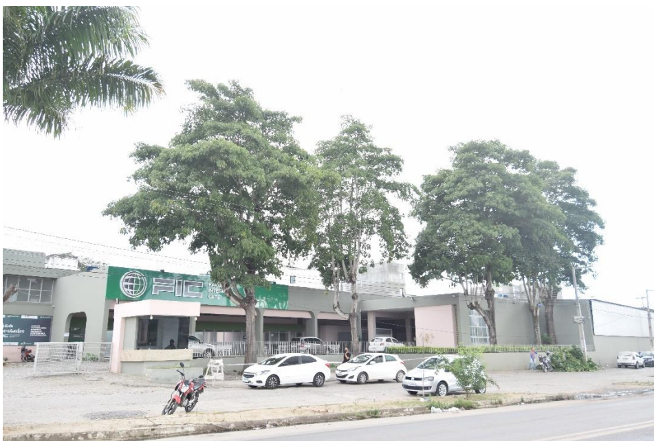
Pintura externa do Prédio da FIC
